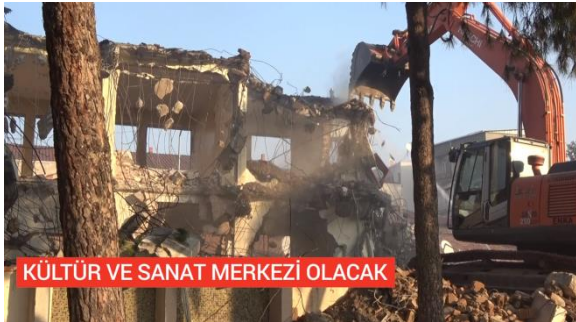
Akhisar Eski Belediye hizmet binası yıkım videosu günleri başladı
